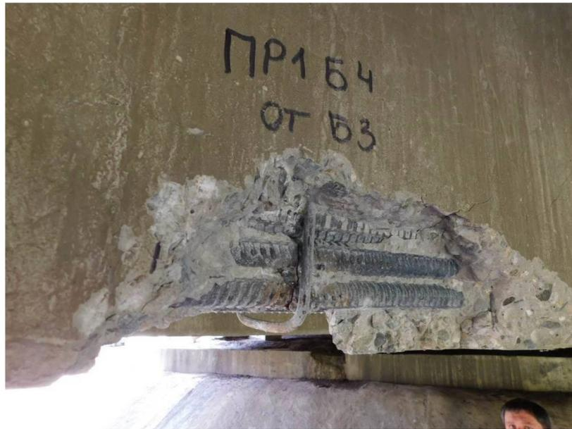
**Рис. 2.** Разрыв двух нижних стержней рабочей арматуры в средней части балки Б4 пролетного строения в пролете 1
