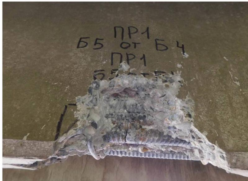
**Рис. 3.** Разрыв двух нижних стержней рабочей арматуры в средней части балки Б5 в пролете 1-пролетного строения моста
