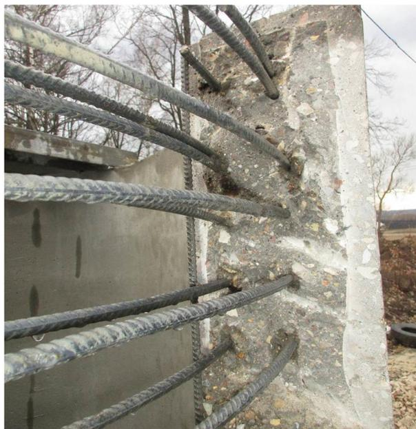
**Рис. 2.** Непроектное расположение кольцевой арматуры по толщине стенки звена трубы
