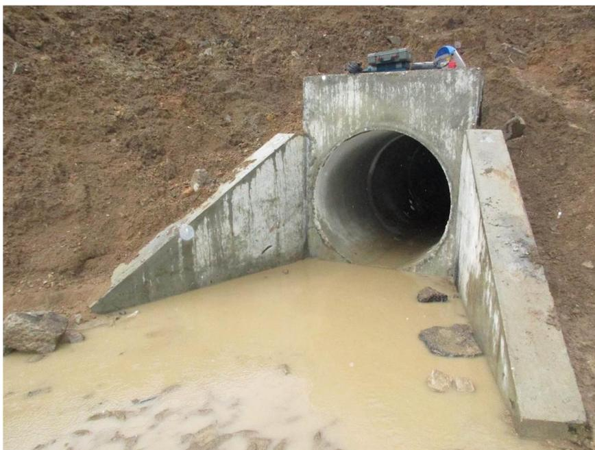
Рис. 1. Входной оголовок порталного типа водопропускной трубы
