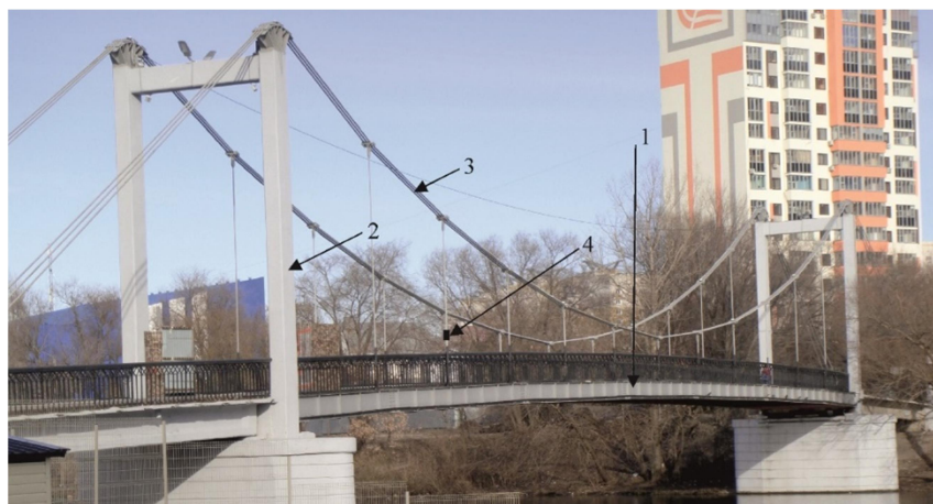
Рис. 1. Общий вид висячего моста, соединяющего левый берег г. Воронежа с Придаченской дамбой Воронежского водохранилища:
