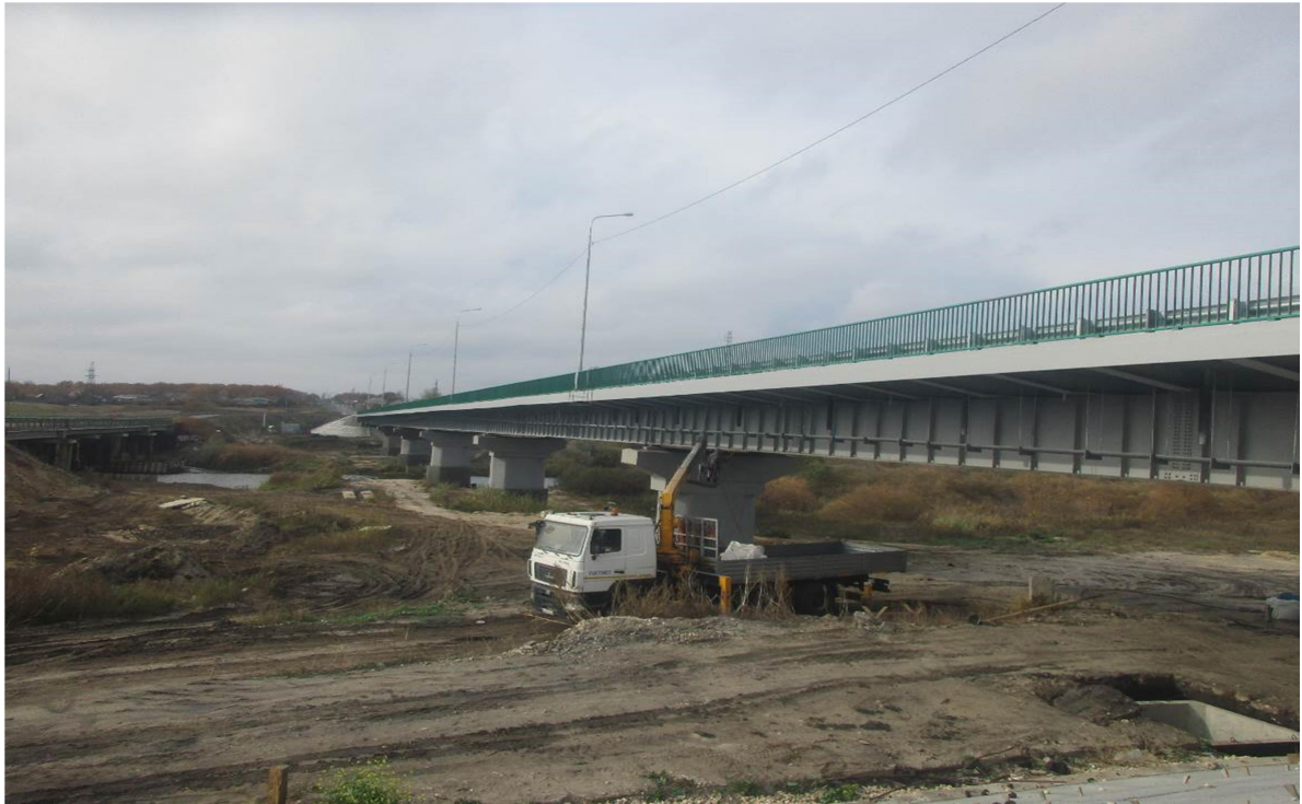
Рис. 1. Общий вид моста с правой стороны от конца сооружения
