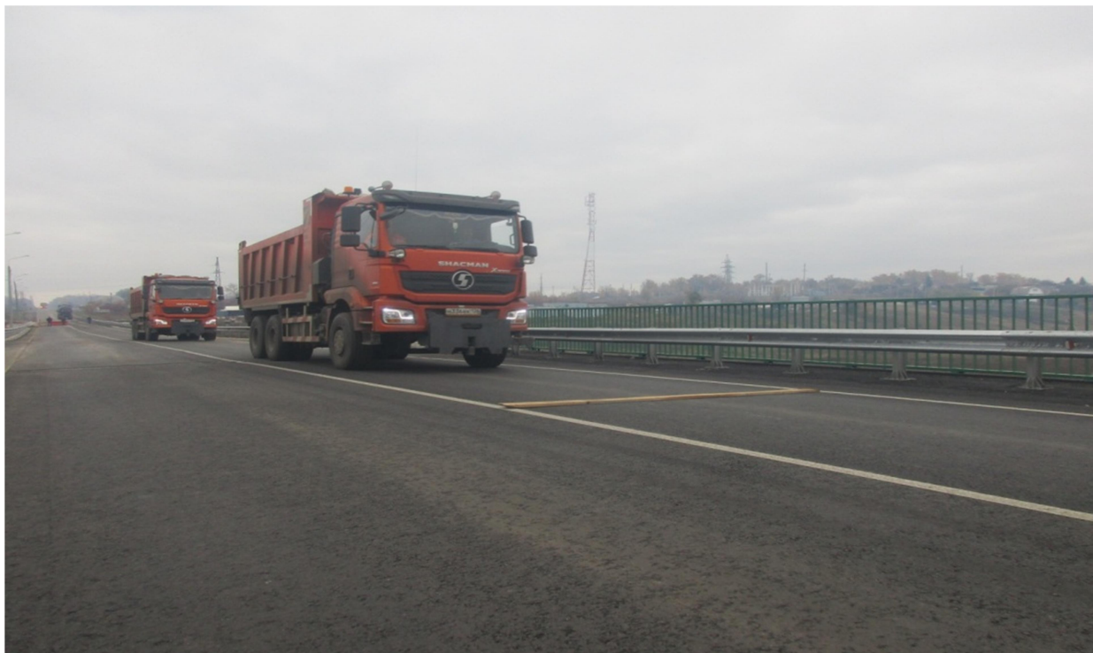
Рис. 3. Проезд грузовых трехосных автомобилей друг за другом через уложенную на проезжей части моста доску толщиной 50 мм
