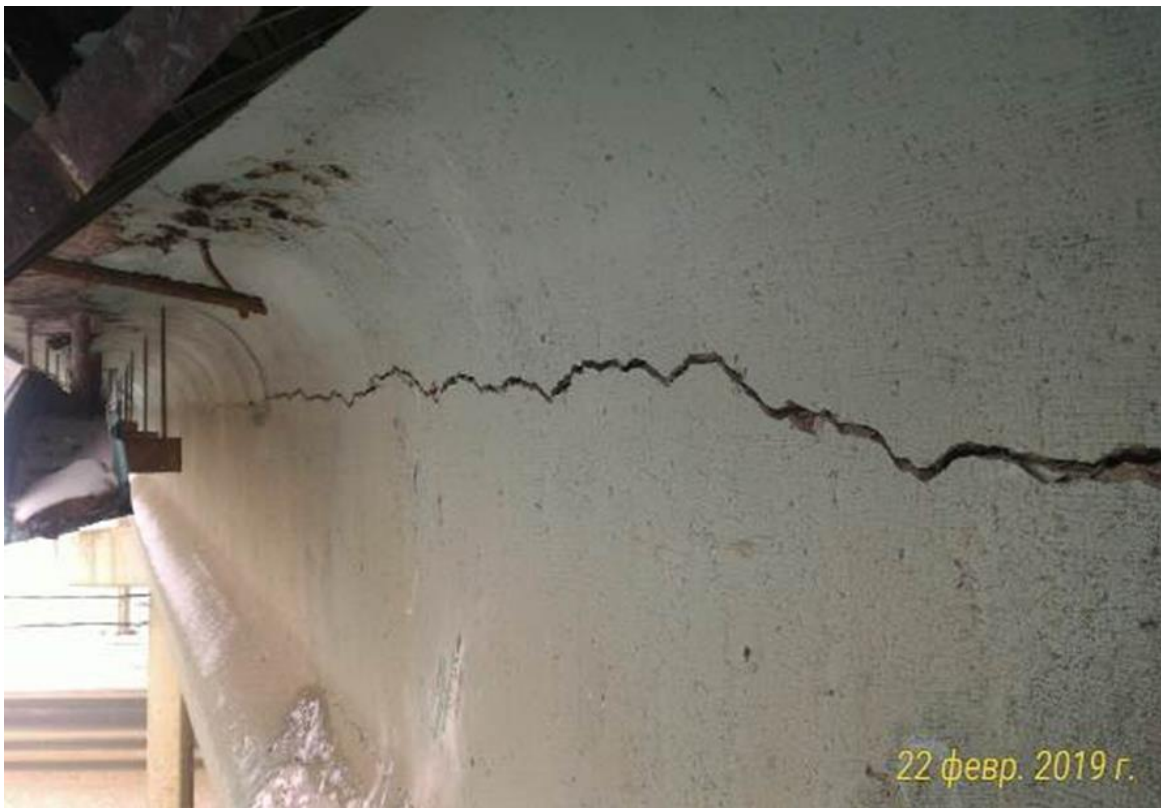
Рис. 2. Магистральная продольная трещина в средней части крайней балки
