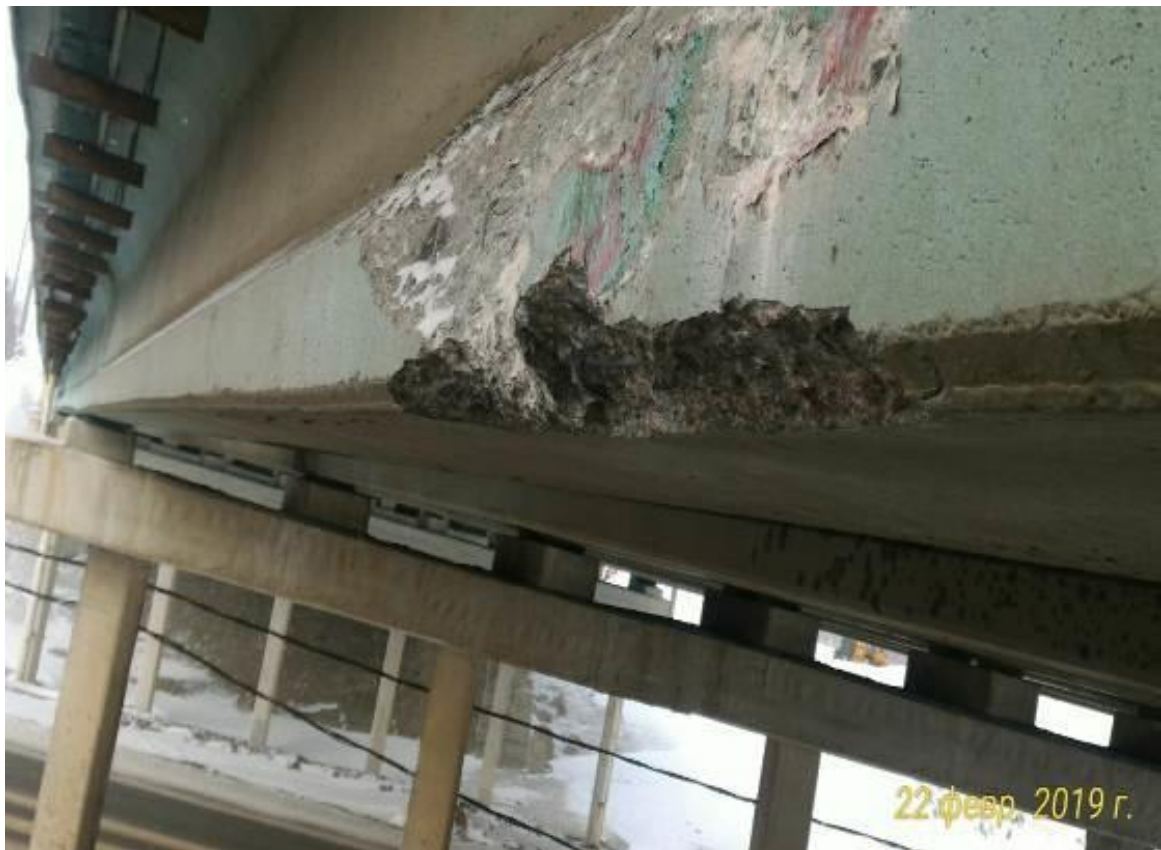
Рис. 1. Фрагмент путепровода в зоне повреждения пролета 2
