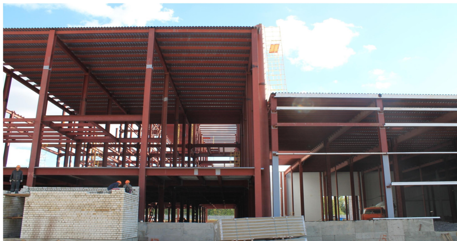
Рис. 2. Общий вид перехода от складского блока к производственной части здания
