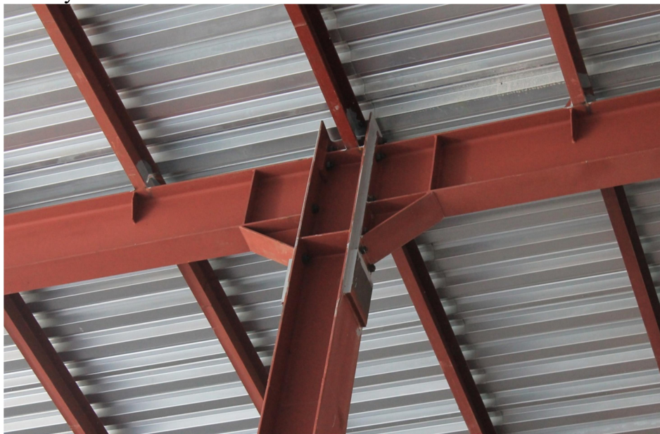
Рис. 1. Общий вид рамного узла сопряжения балок покрытия с колоннами складской части здания
