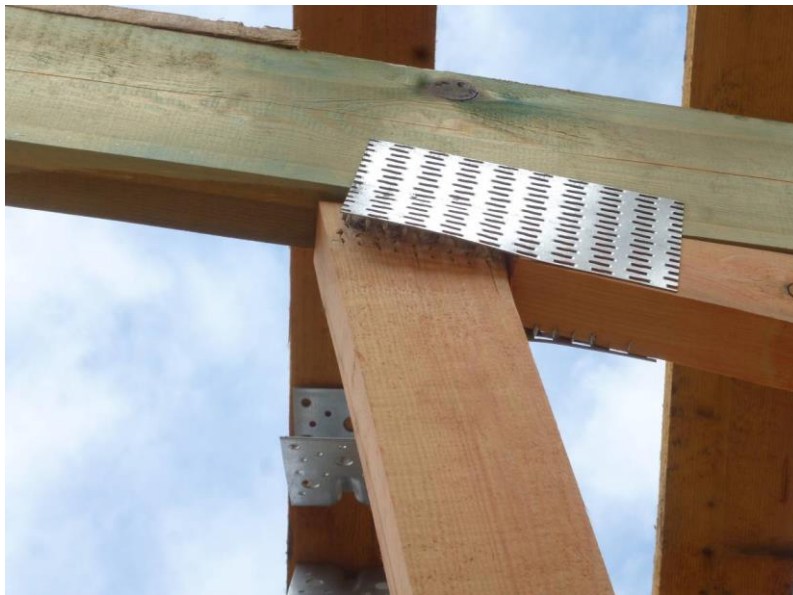
Рис. 10. Разрушение узла
