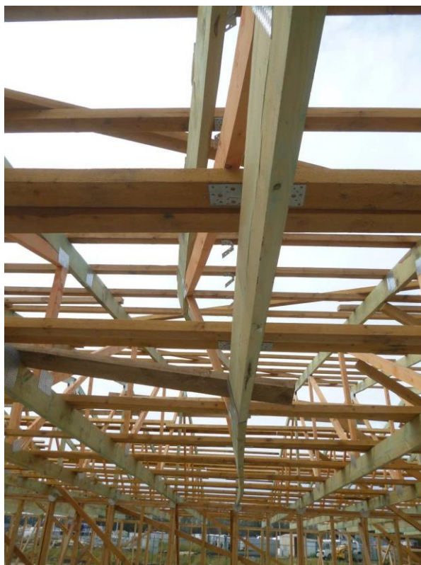
Рис. 9. Искривление нижнего пояса
