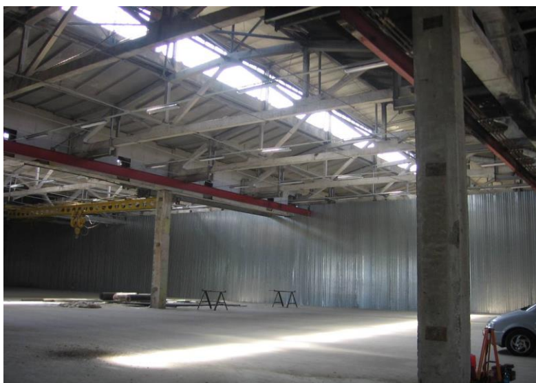
Рис. 2. Общий вид несущей системы изнутри здания с железобетонным несущим каркасом
