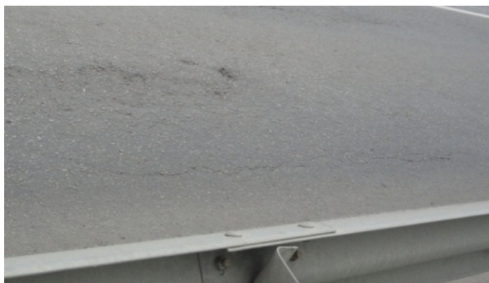
Рис. 1. Продольная трещина над главной балкой в верхнем слое асфальтобетона
