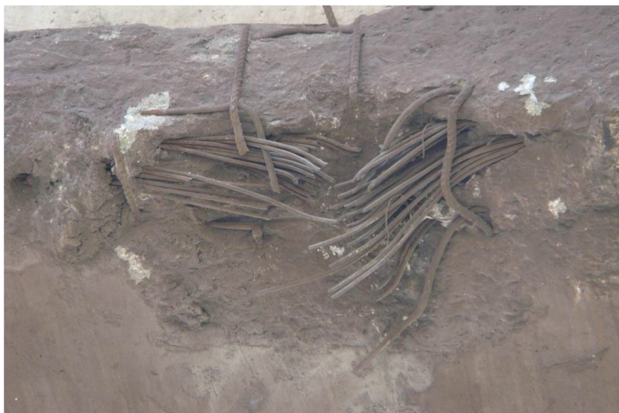
Рис. 1. Нижний пояс поврежденной балки. Разрушение бетона с разрывом рабочей напрягаемой и конструктивной арматуры
