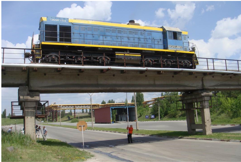
Рис. 2. Испытание пролетного строения на статическую нагрузку
