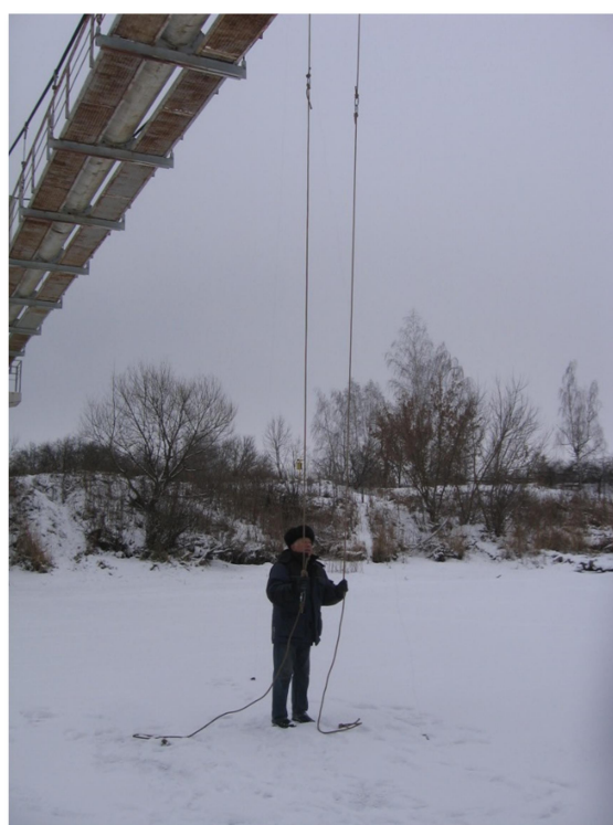
Рис. 4. Тросы для передачи силового воздействия на пролетное строение трубопровода
