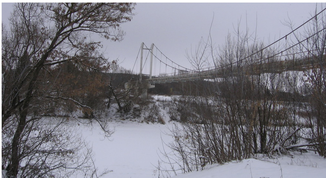
Рис. 1. Общий вид трубопроводного перехода через р. Ока в г. Орел в январе 2015 года
