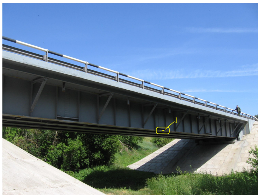
Рис 1. Общий вид пролетного строения с левой стороны: 1 – середина балки Б4
