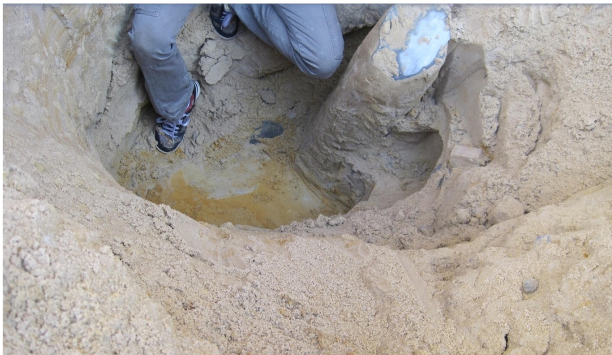
Рис. 5. Вид ствола уплотнения в песчаном грунте в шурфе на отм. 136,9 м
