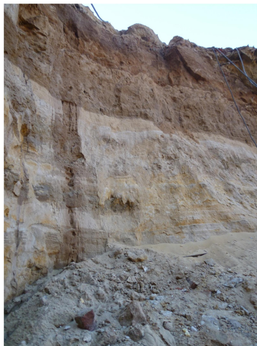
Рис. 3. Неоднородность напластований грунтов в откосе котлована
