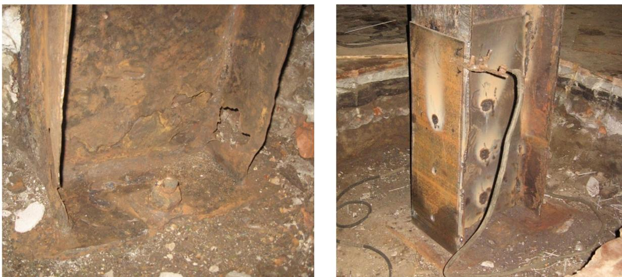
**Рис. 1.** Характерные повреждения и усиление стальных колонн на уровне опорных баз
