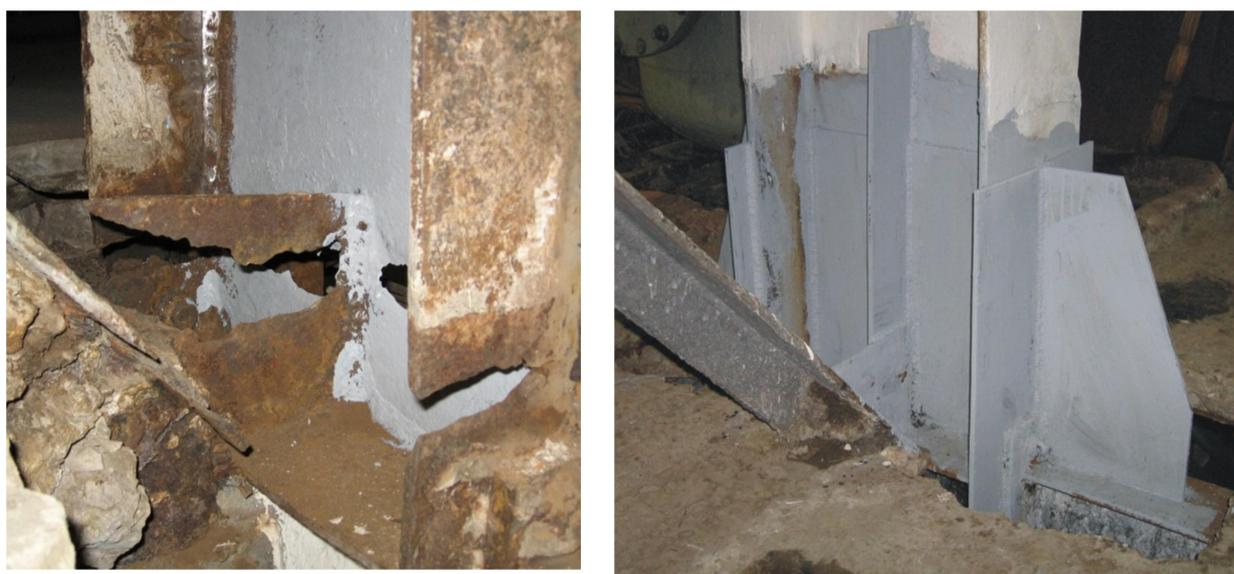
**Рис. 2.** Характерные повреждения и усиление стальных колонн на уровне перекрытий
