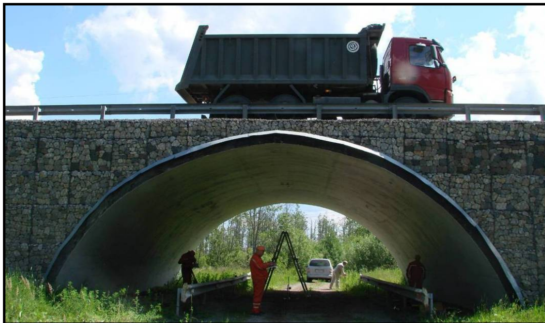
Рис. 1. Общий вид моста при статических испытаниях
