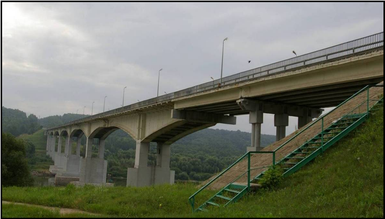
Рис. 1. Общий вид моста со стороны левого берега реки Ока
