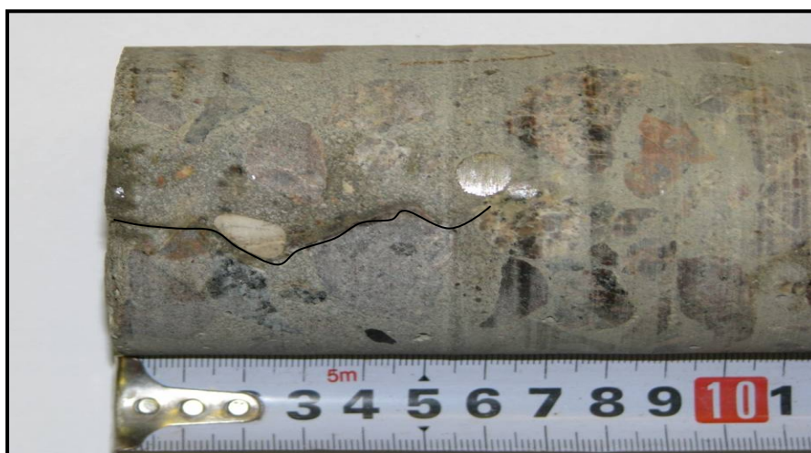
Рис. 5. Глубина распространения трещины в керне № 1
