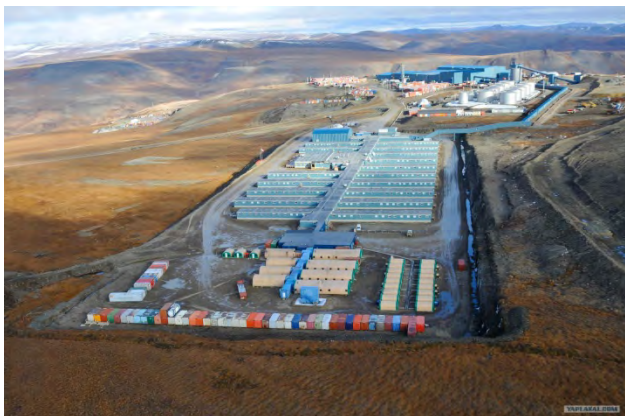
Рис. 10. Вахтовый поселок на золото-серебряном месторождении «Купол»
